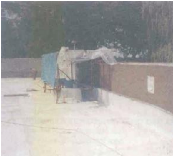
Izolácia stien a dna bazému hydroizolačnou stierkou PCI-Seccoral
