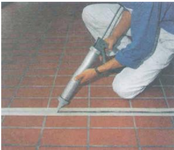
Špárovanie chemicky odolným tmelom PCI-Elribon S
