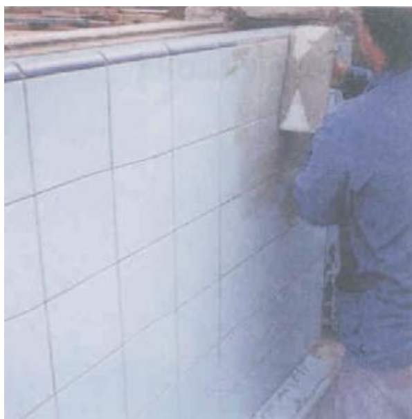
Špárovanie keramického obkladu tmelom na báze epoxidu PCI-Rigamuls S 30
