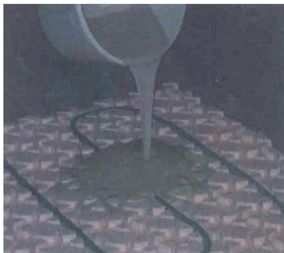
Samonivelačná hmota na báze anhydritu Prince Color N 420 je vhodná na podlahové vykurovanie
