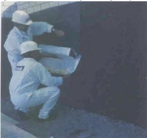
Lepenie samolepiaceho pásu na základové murivo 1
