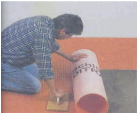
Utesnenie kútov izolačným pásom
