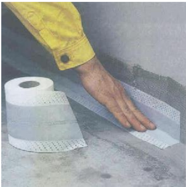
Utesnenie kútov izolačným pásom
