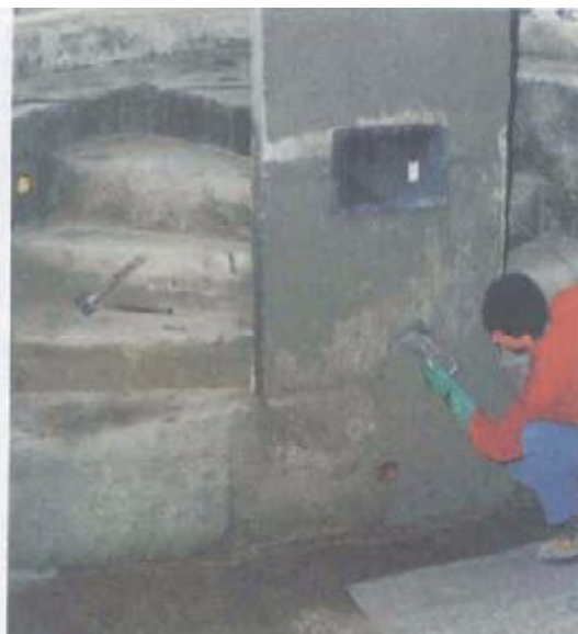
Vyrovnávanie stien bazénu reprofilačnou maltou PCI-Polycrret 20
