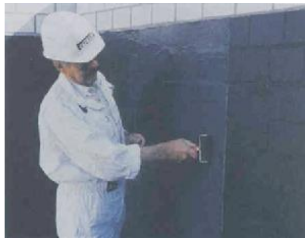
Aplikácia hydroizolačnej stierky
