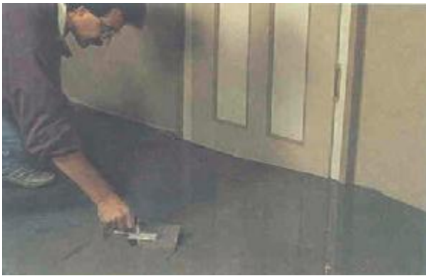
Spracovanie samonivelačnej stierkovej hmoty
