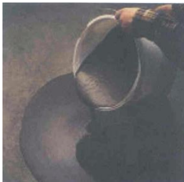
Rozlievanie samonivelizačnej stierkovej hmoty
