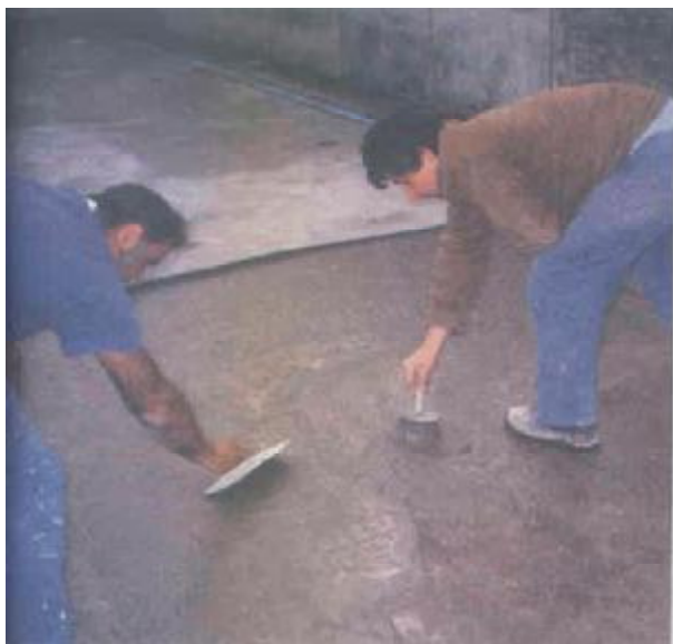
Nanášanie spojovacieho mostíka PCI-Repahaft
